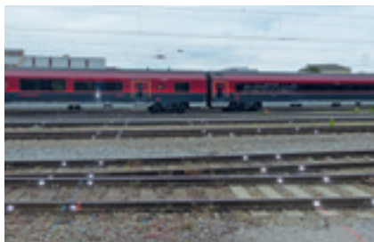
Überwachung einer Gleisanlage
