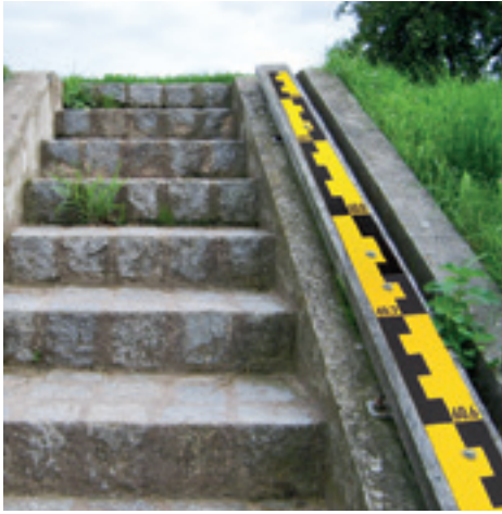
Schrägpegellatte aus Stahl, feuerverzinkt, Sonderanfertigung, bitte sprechen Sie uns an!
