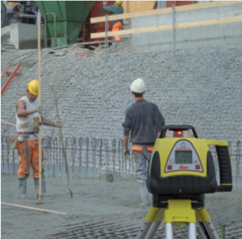
Lasernivelliere sind die „Arbeitsstiere“ unter den Bauvermessungsinstrumenten. Ein Laser ist eine ideale Ergänzung bzw. Alternative zum klassischen Nivellier für viele Routinearbeiten auf der Baustelle.
